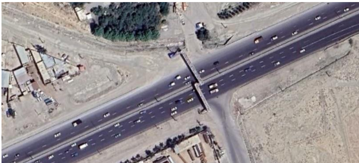
شکل ۲-۹۷: پل شماره ۶ در مسیر محدوده مورد مطالعه
