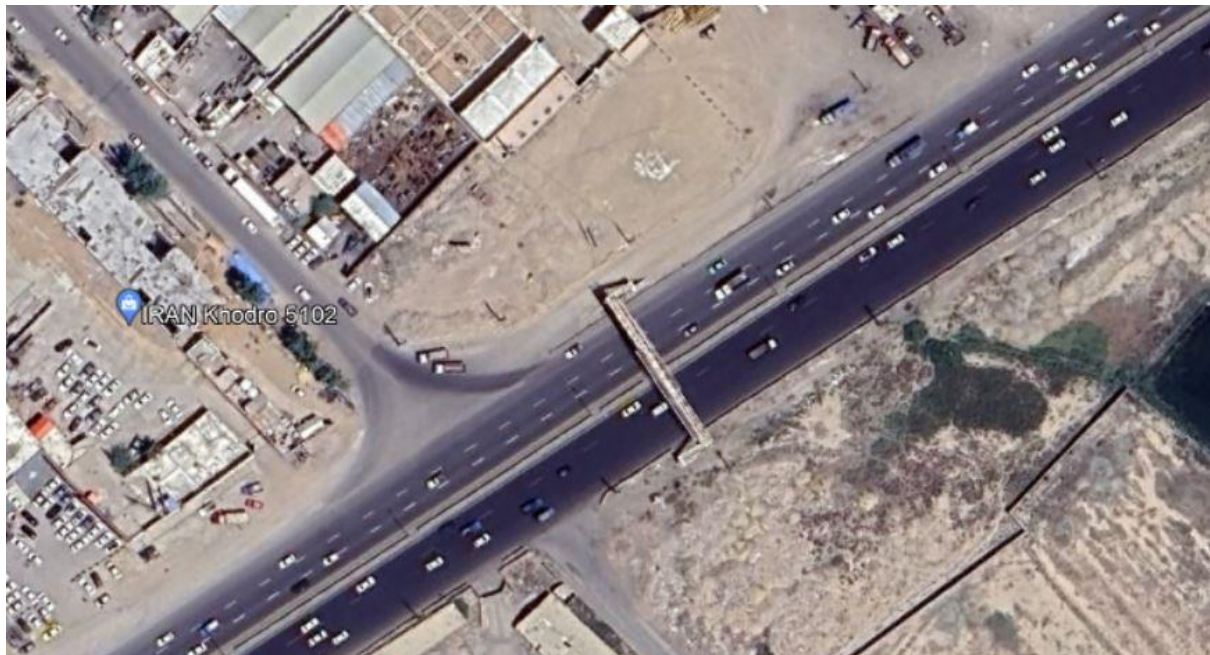
شکل ۹۳-۲: پل شماره ۲ در مسیر محدوده مورد مطالعه
