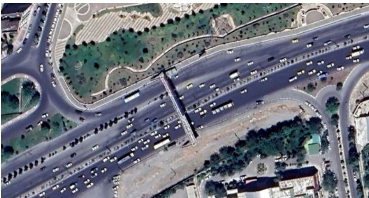
شکل ۲-۹۸: پل شماره ۷ در مسیر محدوده مورد مطالعه
