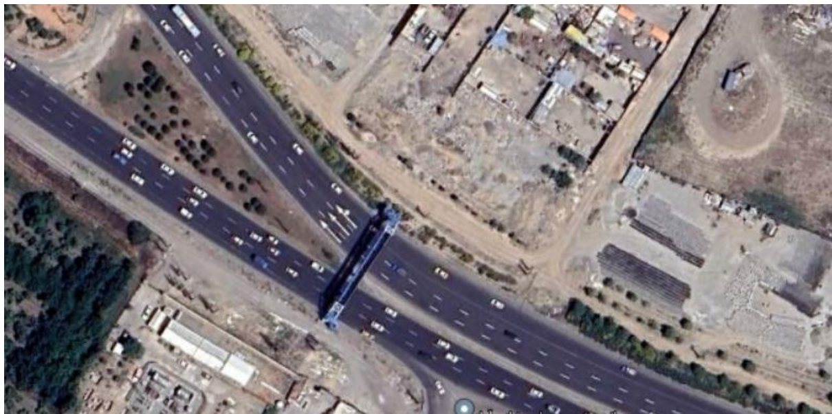
شکل ۹۴-۲: پل شماره ۳ در مسیر محدوده مورد مطالعه
