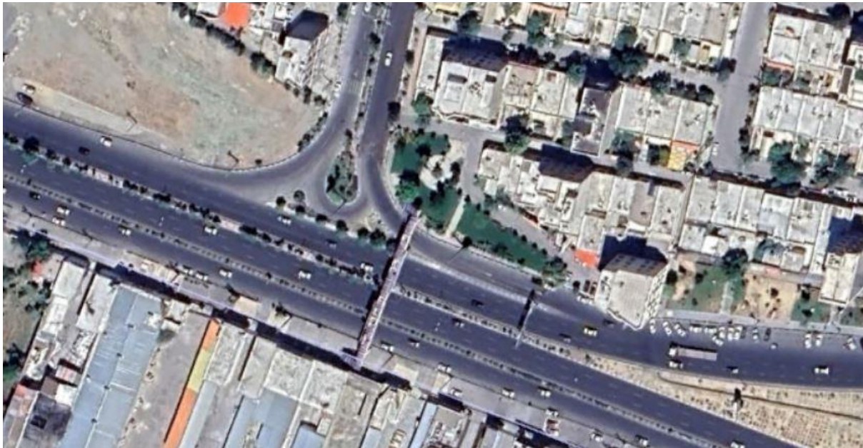
شکل ۱۰۳-۲: پل شماره ۱۱ در مسیر محدوده مورد مطالعه
