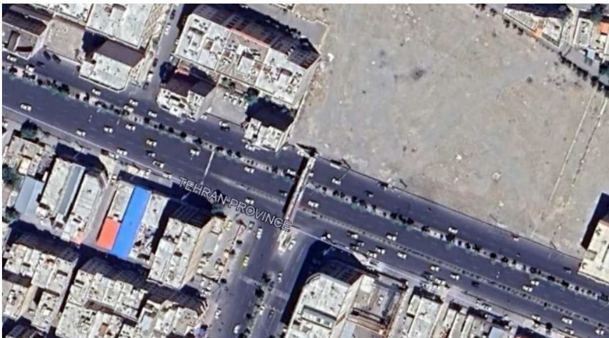
شکل ۱۰۴-۲: پل شماره ۱۲ در مسیر محدوده مورد مطالعه
