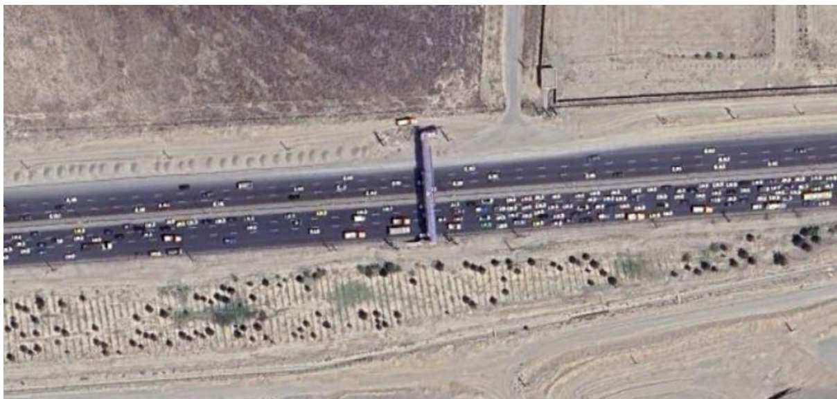
شکل ۹۶-۲: پل شماره ۵ در مسیر محدوده مورد مطالعه
