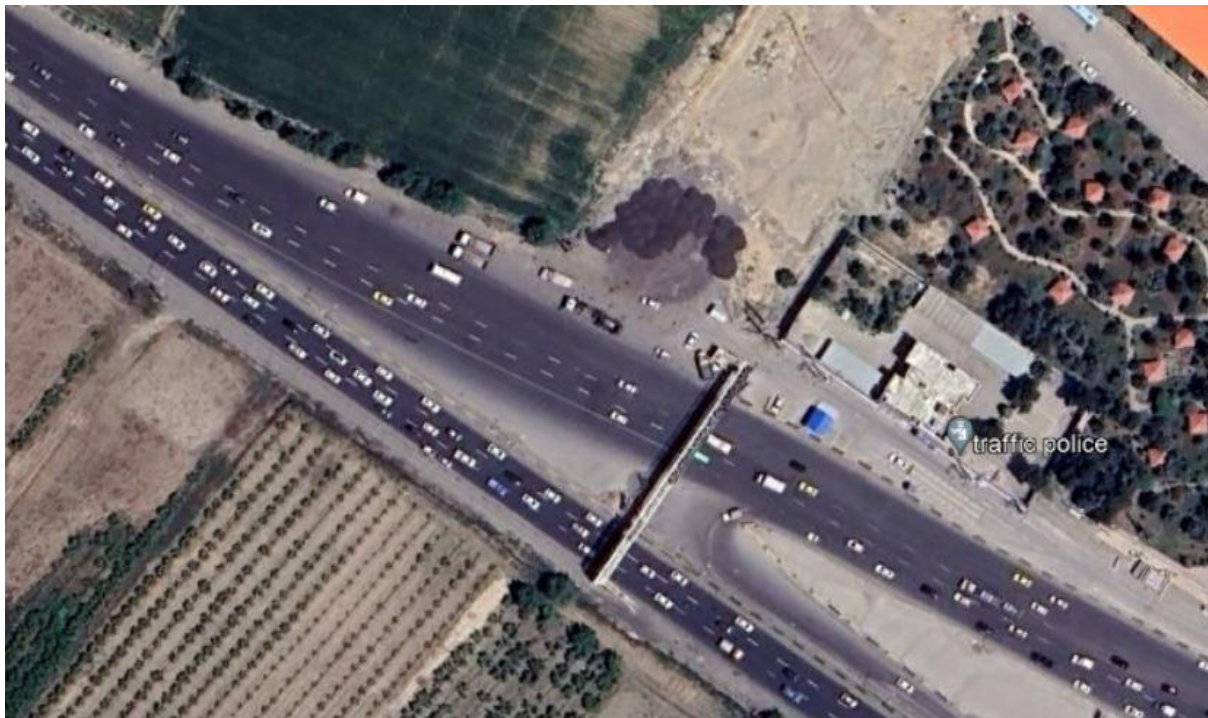
شکل ۹۵-۲: پل شماره ۴ در مسیر محدوده مورد مطالعه
