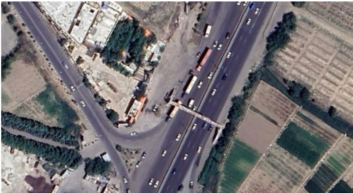
شکل ۲-۹۲: پل شماره ۱ در مسیر محدوده مورد مطالعه
